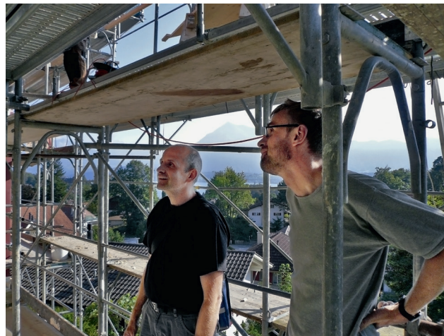
L'architecte du Service des monuments historiques suit les travaux sur place. Photo 2006 (Hans Beutler).
