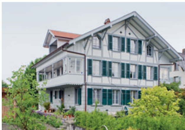
Münsingen, Schulhausgasse 8. Wohnhaus aus der Zeit um 1896. Der charakteristische Riegbau mit Holzstildekor entging nur knapp dem Abbruch. 2009 begleitete die Denkmalpflege den Umbau (Flury und Rudolf Architekten AG, Solothurn). Foto 2011 (Beat Schertenleib).
