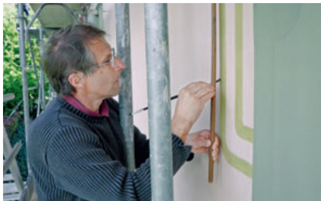
Thoune, Riedstrasse 45. Reconstitution d'un décor de style Art nouveau sur la villa Viola construite vers 1905. Restauration extérieure par Beutler Breitenstein Röthlisberger Architekten AG, Thoune. La restauration a reçu le prix des monuments historiques 2011, décerné par le Service des monuments historiques du canton de Berne. Photo 2006 (Hans Beutler).
