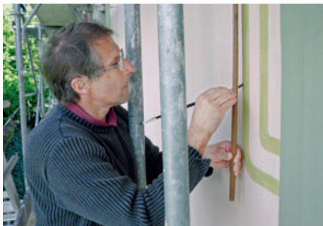
Thun, Riedstrasse 45. Wiederherstellung einer Jugendstil-Dekorationsmalerei am Wohnhaus «Viola», erbaut um 1905. Die Aussenrestaurierung (Beutler Breitenstein Röthlisberger Architekten AG, Thun) wurde mit dem Denkmalpflegepreis 2011 ausgezeichnet. Foto 2006 (Hans Beutler).
