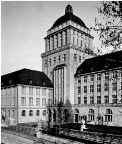
Abb. 7a+7b: Vergleich von Universität Zürich (links) und Pro gymnasium Thun (rechts): Anlage und Massengruppierung mit dem rhythmisierten Längstrakt und dem Kontrapunkt des Turms entspringen noch dem malerischen Empfinden der Reformarchitektur des frühen 20. Jh. Diese zunächst in England und Nordamerika gepflegte Entwurfsidee für asymmetrische Baukörper bestimmt auch den Bau der Universität in Zürich (Karl Moser und Robert Curjel, 1911–1914) und drang weit ins moderne Bauen hinein. Architekt Balmer reduzierte zwar Formen und Dächer, bezog sich ansonsten aber unübersehbar auf die Zürcher Anlage mit ihrem kräftigen städtebaulichen Vertikalakzent, der Arkadenvorhalle (vgl. Abb. 6) und dem bahntypisch verglasten Treppenhaus. (Aus: Hildebrand, Sonja und Oechslin, Werner (Hrsg.), Karl Moser. Architektur für einen neuen Zeit, 2 Bde., Bd. 1, Zürich 2010, S. 35), Foto 2009 (Andrea Zellweger).
