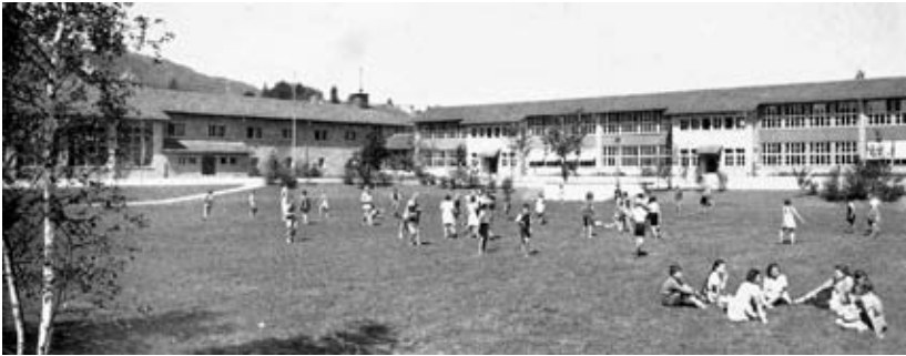
Abb. 13: Zürich-Wollishofen, Primarschulhaus (1948, Architekten: Kräher, Bosshardt & Forrer): Die illustrierte Besprechung dieses Zürcher Schulhauses in der «Schweizerischen Bauzeitung» könnte Karl Müller-Wipf zur konkreten Ausarbeitung des Entwurfs des Länggass-Schulhauses angeregt haben, nicht zuletzt weil er in den 1930er-Jahren beim Architekten Edwin Bosshardt in Winterthur angestellt war. Weitere vergleichbare Konzepte sind bis in die frühen Kriegsjahre zurückzuverfolgen. (Schweizerische Bauzeitung, 66. Jg (1948), Taf. 3).
