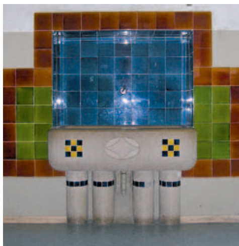
Abb. 4: Pestalozzi-Schulhaus. Waschbecken in Form eines Wandbrunnens, gestaltet in Anlehnung an Arbeiten des Lörracher Künstlers Max Läger (1864–1952). Grosse Korridore und fliessendes Wasser in jedem Stock waren um 1910 noch eine Neuheit, und die Keramik- kacheln, geradezu ein Symbol der Hygiene, sollten mit ihrer Buntheit auffallen und dadurch zur Reinlichkeit erziehen. Foto 2006 (Matthias Walter).
