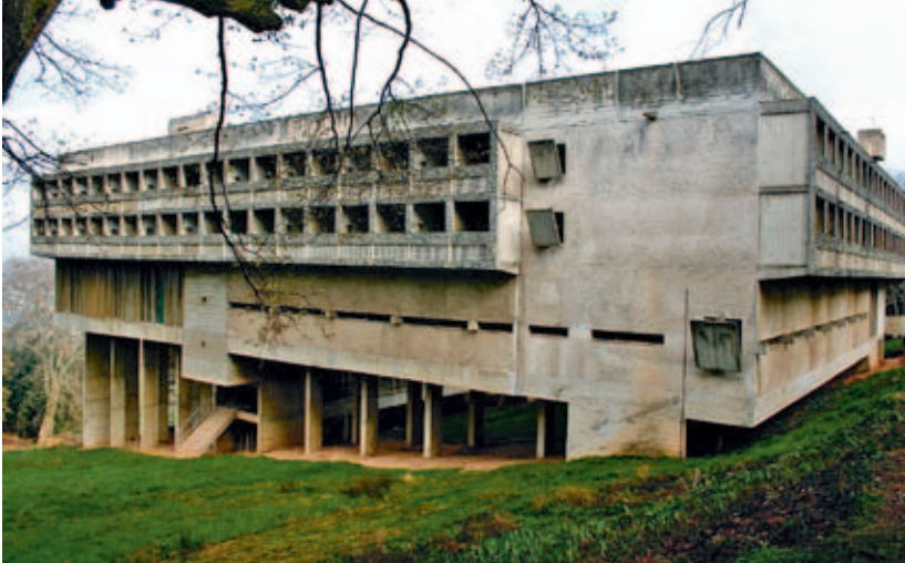
Abb. 18: Eveux (Frankreich), Kloster Ste-Marie-de-la-Tourette (1957–60 von Le Corbusier): Die massive, entsprechend skulpturartig wirkende Betonschachtel-Architektur mit ihren Hell-Dunkel Kontrasten zwischen Fenstern und Betonstützen war ein Bauprinzip, das in den 1960er-Jahren besonders auf Le Corbusiers Grundlage gepflegt wurde und auch in der Schönau-Schule nachwirkt (aus: http://de.wikipedia.org/wiki/Sainte-Marie_de_la_Tourette ).
