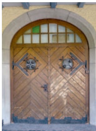
Abb. 5a+5b: Pestalozzi-Schulhaus. Dass auch die Turnhalle in ihrer äusseren Erscheinung einem Wohnhaus ähnelt, unterstreicht die Bedeutung der damaligen Heimatbewegung. Typisch für die Bemühungen um die spezifische Identifikation von Gebäuden sind die einfallsreichen Schmiedearbeiten von Sportgeräten an den Türgittern. Blaupause 1908 im Stadtarchiv Thun, Foto Matthias Walter, Foto 2009 (Andrea Zellweger).
