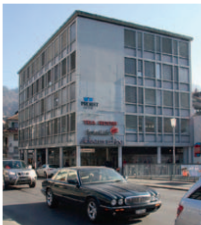
Wohn- und Geschäftshaus Marktgasse 17, 2011.
