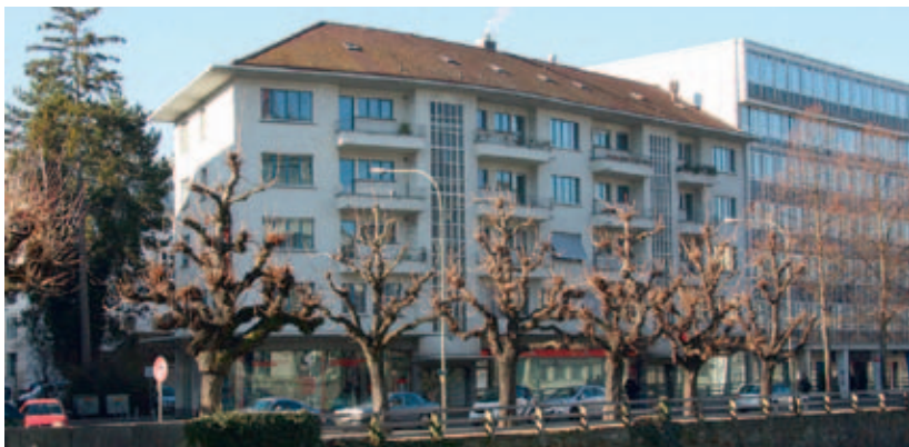
Wohn- und Geschäftshaus an der Aarestrasse 40, aufgenommen 2011.
