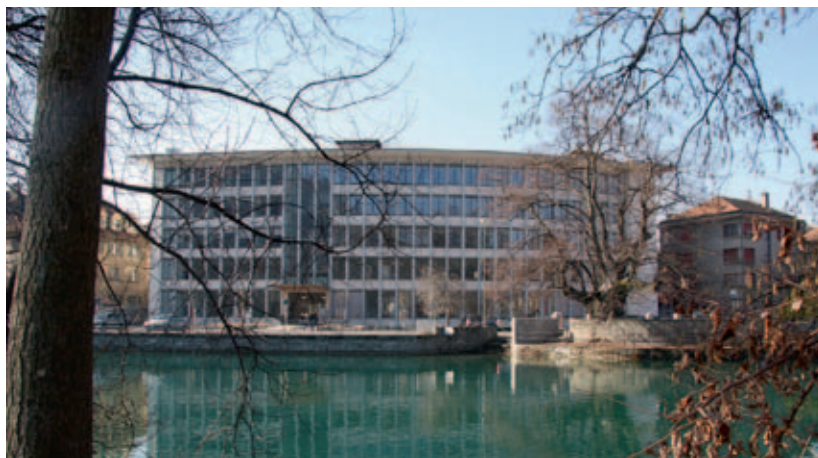
Ehemaliges Verwaltungsgebäude der Firma Selve, heute kantonale Bezirksverwaltung, an der Scheibenstrasse 3, aufgenommen 2011 nach der Renovation.
