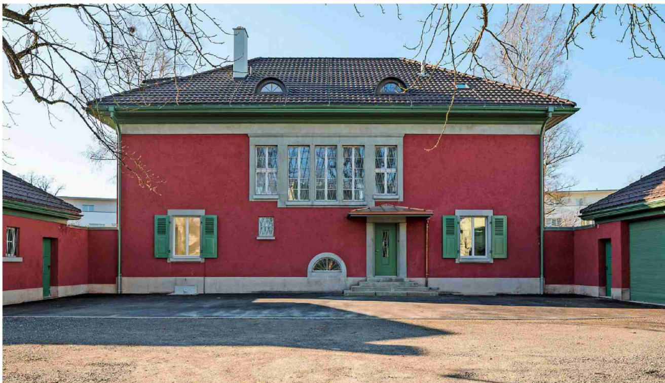
Neues Dach, neue Fenster, die Farbe von Himbeeren an der Fassade: So präsentiert sich die Villa Geiser nach der Sanierung. Foto: PD/P*Inc. AG
