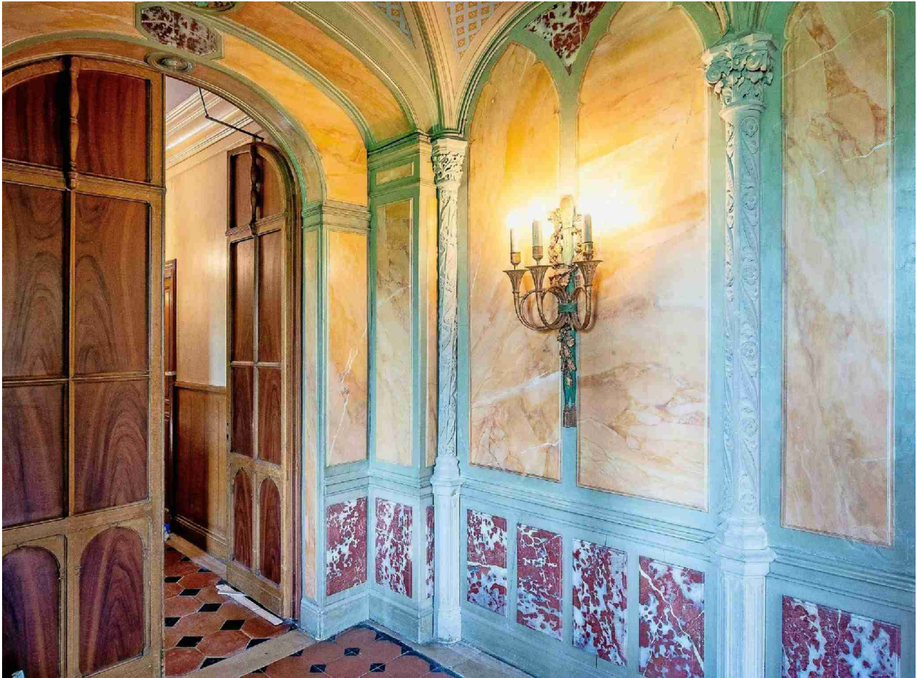
Im Obergeschoss befinden sich neu die Hotelzimmer. Deren Zugang führt vom Korridor her, dessen Wände neu marmoriert wurden. Fotos: Patric Spehni
