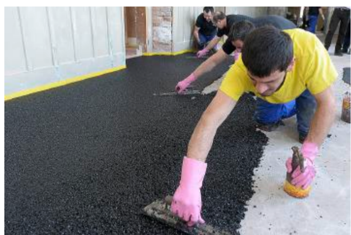
Ein neuer Belag: Arbeiter spachteln das moderne Gummigranulat in einem der Schulhausgänge auf.
