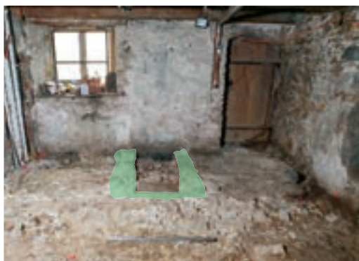
Abb. 5: Twann-Tüscherz, Dorf-gasse 9c. Erd-geschoss mit Kachelofen-fundament (grün). Rechts, die ursprüngliche Tür; links, das Doppelfenster aus dem späten 17. Jahrhundert.
