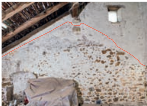
Abb. 3: Twann-Tüscherz, Dorf-gasse 9c. Nord-mauer mit Abdruck des ursprünglichen Daches (rote Linie); in der Ecke links unten, das ursprüngliche Fenster (31).
