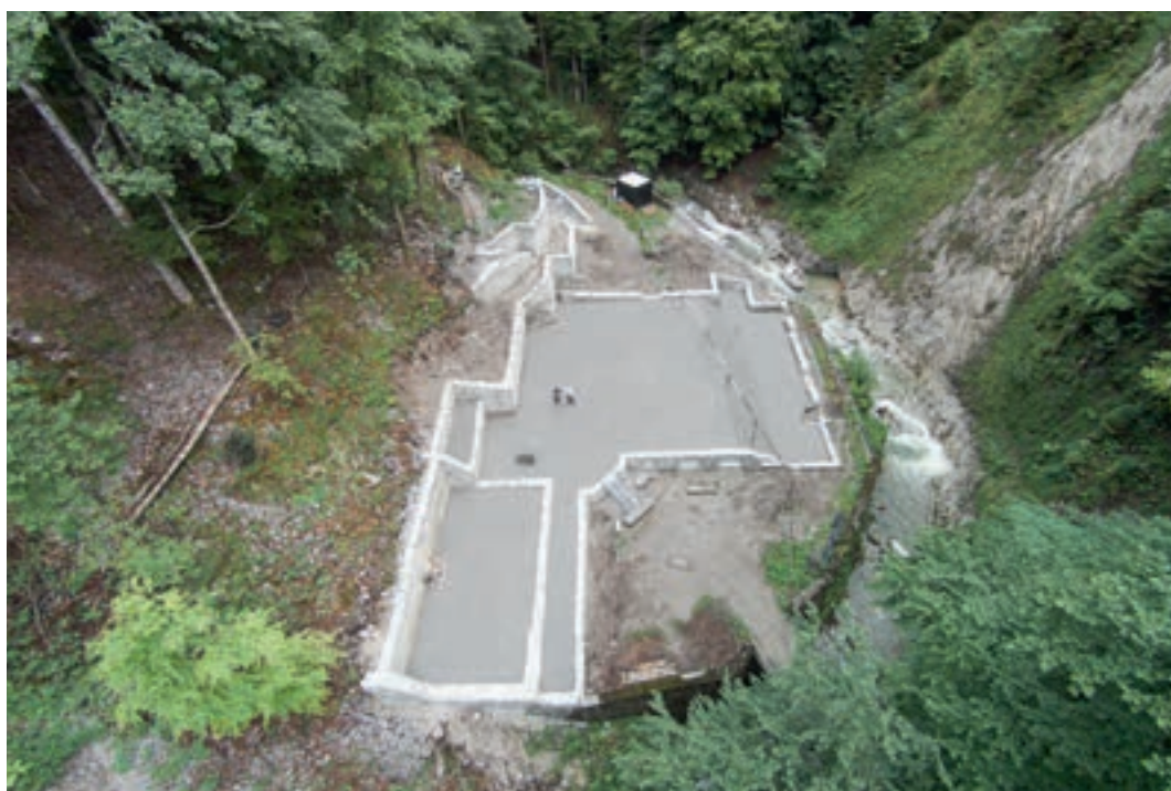
Abb. 1: Oberwil i. S., Bad Weissenburg. Hinteres Bad nach der Sanierung im August 2015. Drohnensfoto.
