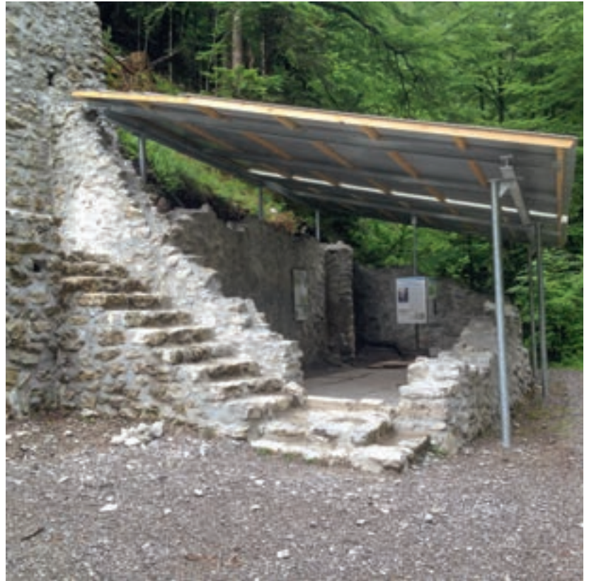
Abb. 4: Oberwil i. S., Bad Weissenburg. Das ehemalige Metzgereigebäude mit Schutzdach und Informationstafeln im Sommer 2016.
