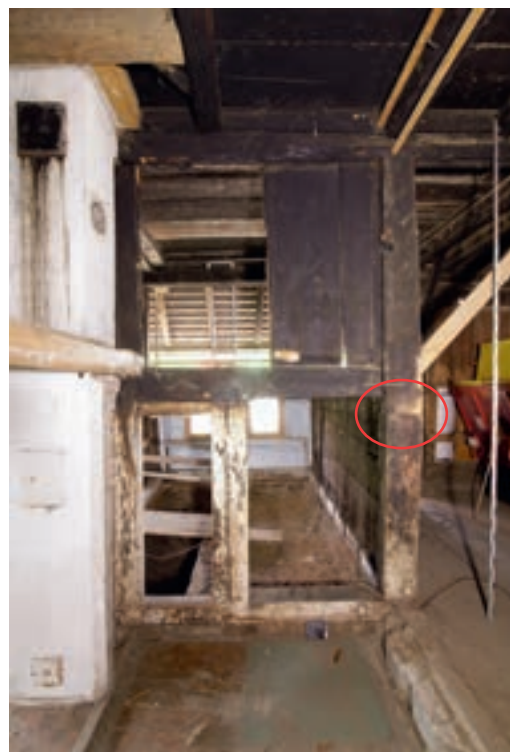
Abb. 3: Lützelflüh, Moosmatt 727a. Die zweigeschossigen Eckständer wurden aus jeweils zwei Hölzern errichtet. Diese aufeinandergestellten Ständer sind nicht kraftschlüssig und zeigen daher einen deutlichen Verzug. Blick nach Nordosten.
