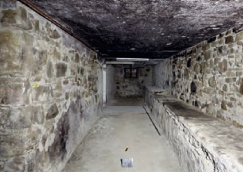
Abb. 3: Blumenstein, Badstrasse 37. Am linken Bildrand ist die Aussen-mauer des ältesten Kellers aus der Zeit um 1600 ersichtlich. Rechts der Unterbau der Veranda von 1879. Der lange, schmale Gang wurde erst nach den Umbauten im Jahr 1932 erschlossen. Blick nach Norden.
