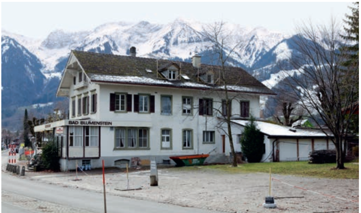
Abb. 1: Blumenstein, Badstrasse 37. Die Ansicht zeigt den baulichen Zustand von 1879 vor der Sanierung im Jahr 2016. Die geschlossene Veranda stammt von 1932. Blick nach Süden.
