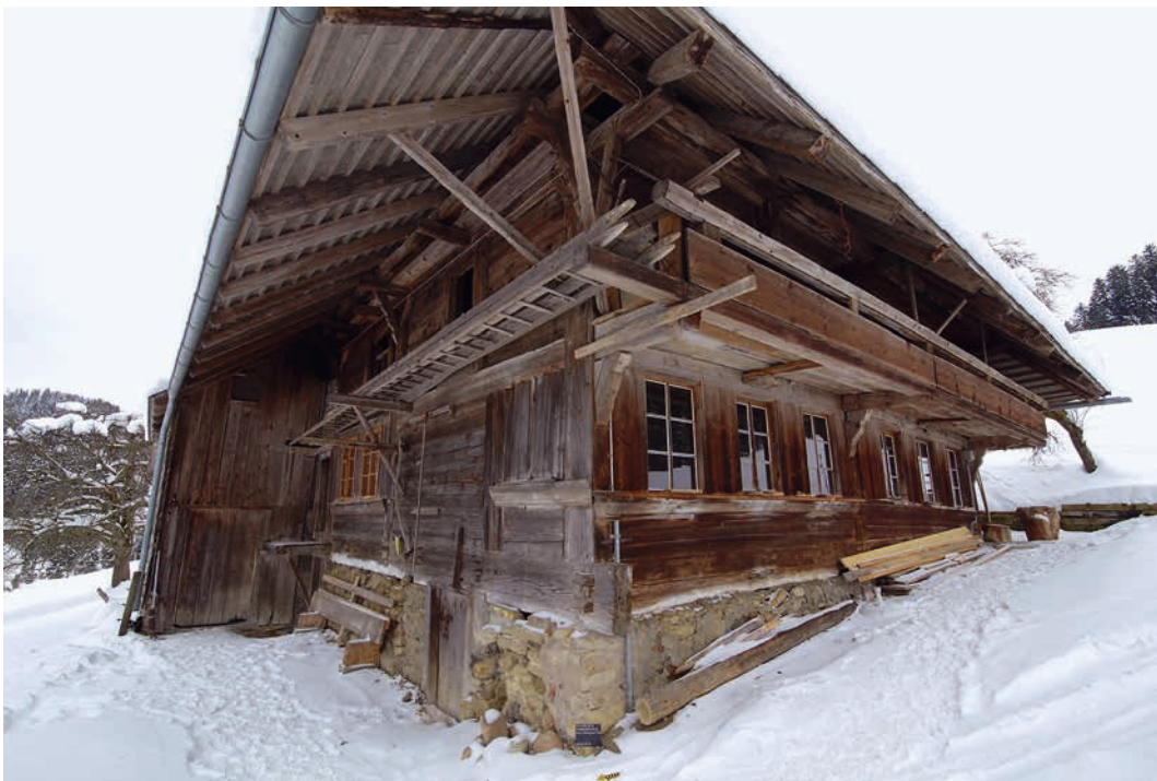
Abb. 1: Trachselwald, Vorder Giselguet 146. Die starke Hanglage ist gut zu erkennen. In der Nordfassade zeigt sich die Kellertüre, über dem gemauerten Sockel liegt der mächtige Schwellenkranz mit Zapfenschloss. Nordseitig in der Ecke ist das mit Brettern verschlossene letzte originale Fenster zu sehen. Blick nach Südosten.
