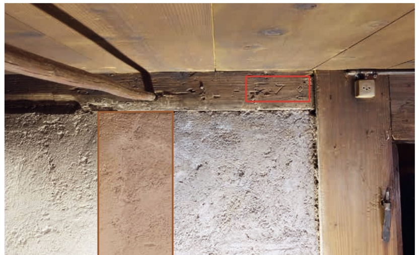
Abb. 2: Trachselwald, Vorder Giselguet 146. Ehemals lag die Verbindungstüre zwischen Stube und Küche stärker im Norden, dies ist noch an der Fase mit Abwurf im Rähm zu erkennen. Braun eingefärbt wurde die ungefähre Lage des Türständers. Mittig über dieser ehemaligen Stubentür ist die Jahreszahl eingeschnitten, zu lesen sind noch die Zahlen «170..» (rotes Viereck). Blick nach Osten.
