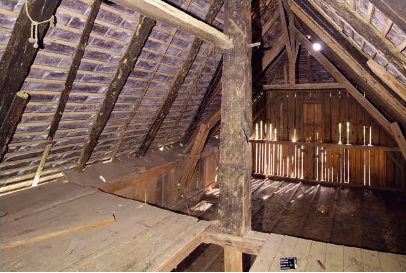
Abb. 5: Seedorf, Saumweg 3. Hinter dem rauchgeschwärzten Firstständer und dem zugehörigen Dachwerk von 1608/09 erkennt man den liegenden Dachstuhl des Ökonomieteils aus der Zeit um 1900. Blick nach Südwesten.
