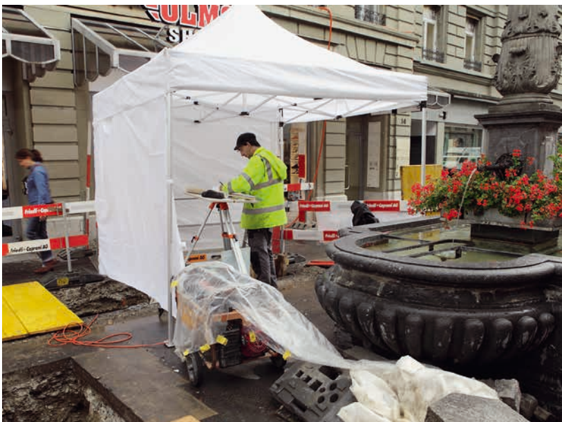
Abb. 1: Bern, Zeughausgasse. Neben dem Lindenbrunnen erfolgte der Neubau einer Trafostation. Zudem musste hier ein gassenquerender Leitungsgaben neu angelegt werden. Blick nach Nordosten.
