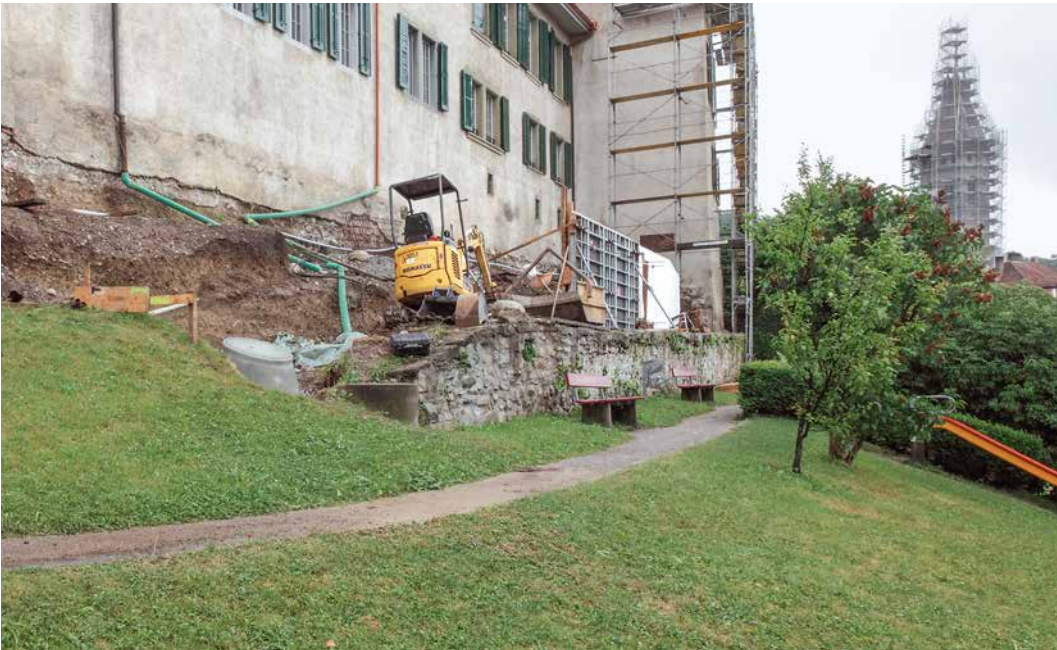
Abb. 2: Thun, Schloss. Baustelle auf der südlichen Schlossterrasse im Sommer 2014. Blick nach Osten.
