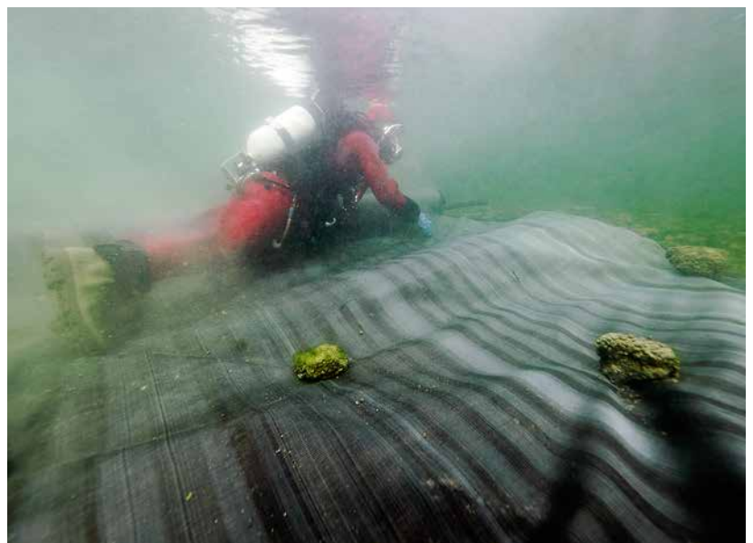
Abb. 4: Sutz-Lattrigen, Rütte. Über der Erosionskante werden als Schutzmassnahme Geotextile ausgebracht, die dann mit einer Kiesschüttung beschwert werden.
