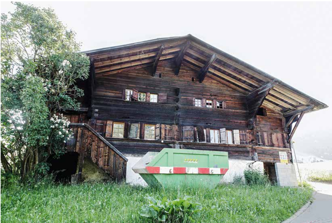
Abb. 1: Saanen-Gstaad, Litzistrasse 21. Die westliche Hauptfassade des Bauernhauses war ursprünglich schmaler. Die ehemaligen Seitenlauben sind nachträglich zu Räumen ausgebaut worden. Zur Bauzeit führten noch beidseitig Treppenaufgänge zu den Seitenlauben. Blick nach Osten.
