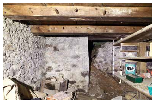
Abb. 2: Saanen-Gstaad, Litzistrasse 21. Die Ostwand im südlichen Kellerraum weist einen auffälligen Versatz auf. Auf zwei Dritteln der Länge ist sie um 1,4 m nach Osten versetzt. Der Grund hierfür bleibt unbekannt. Blick nach Osten.
