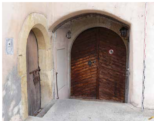
Abb. 6: Ligerz, Chlyne Twann 7. Erdgeschoss. Direkt neben dem südseitigen Haupteingang in den grossen Kellerraum wurde fassadenparallel ein kleinerer Gewölbekeller angefügt. Das Gewände ist im unteren Bereich ausgebuchtet, damit die grossen Weinfässer durchgeschoben werden konnten. Blick nach Nordwesten.
