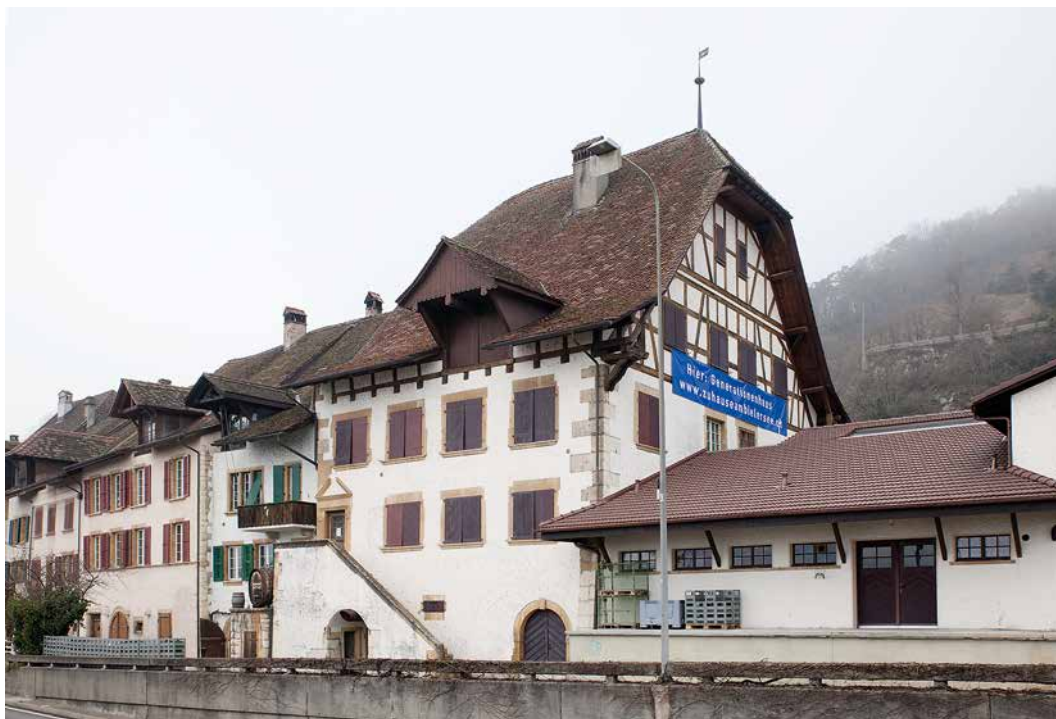
Abb. 7: Twann, Chlyne Twann 20. Südfassade, Ansicht von der Seeseite mit dem nachträglich angefügten Treppenaufgang.
