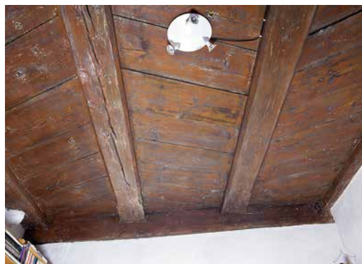
Abb. 5: Ligerz, Chlyne Twann 7. Zweites Obergeschoss. Die Decke im östlichen Saal wurde mit fischgrätförmig eingeschobenen Bohlen gebaut; die einzelnen Hölzer verfügen über eine Strichzier. Blick nach Nordwesten.
