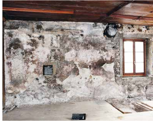
Abb. 3, links: Urtenen, Solothurnstrasse 53, Blick nach Südosten in den Keller des Kernbaus.
