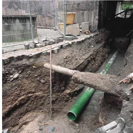
Abb. 3: Thun, Schloss. Leitungsgraben im Hof mit der ältesten Abbruchschicht im unteren Profilabschnitt. Blick nach Nordosten.
