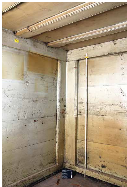
Abb. 2: Saanen-Gstaad, Schibeweg 36. Reich verzierte Wand- und Deckenkonstruktion der Stube im Erdgeschoss (Raum 110). Blick nach Süden.
