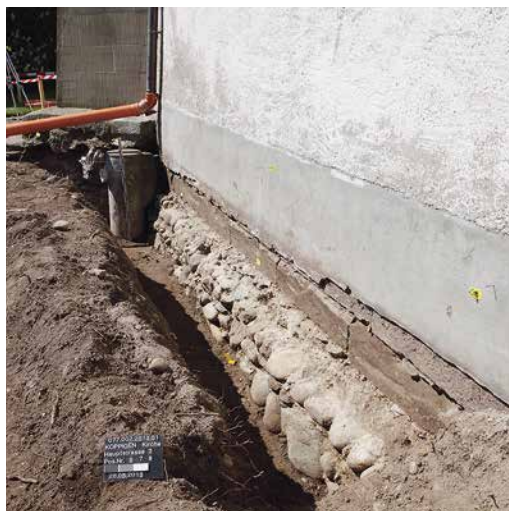
Abb. 3: Koppigen, Hauptstrasse 3. Ostseite des Hauptchores mit dem freigelegten Feldsteinfundament. Blick nach Süden.
