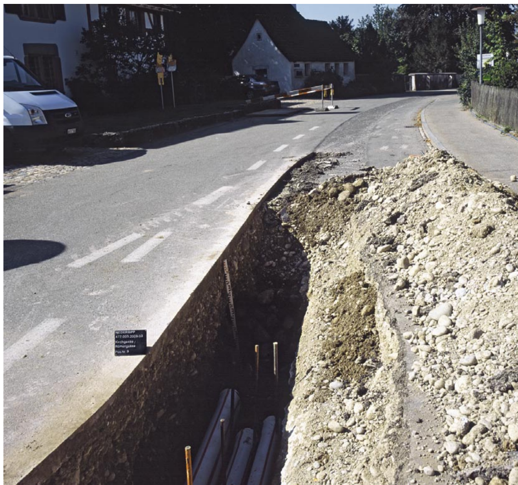
Abb. 1: Niederbipp, Kirchgasse. Werkleitungssanierung 2009. Im Vordergrund angeschnittene Grabgrube 23. Blick nach Westen.
