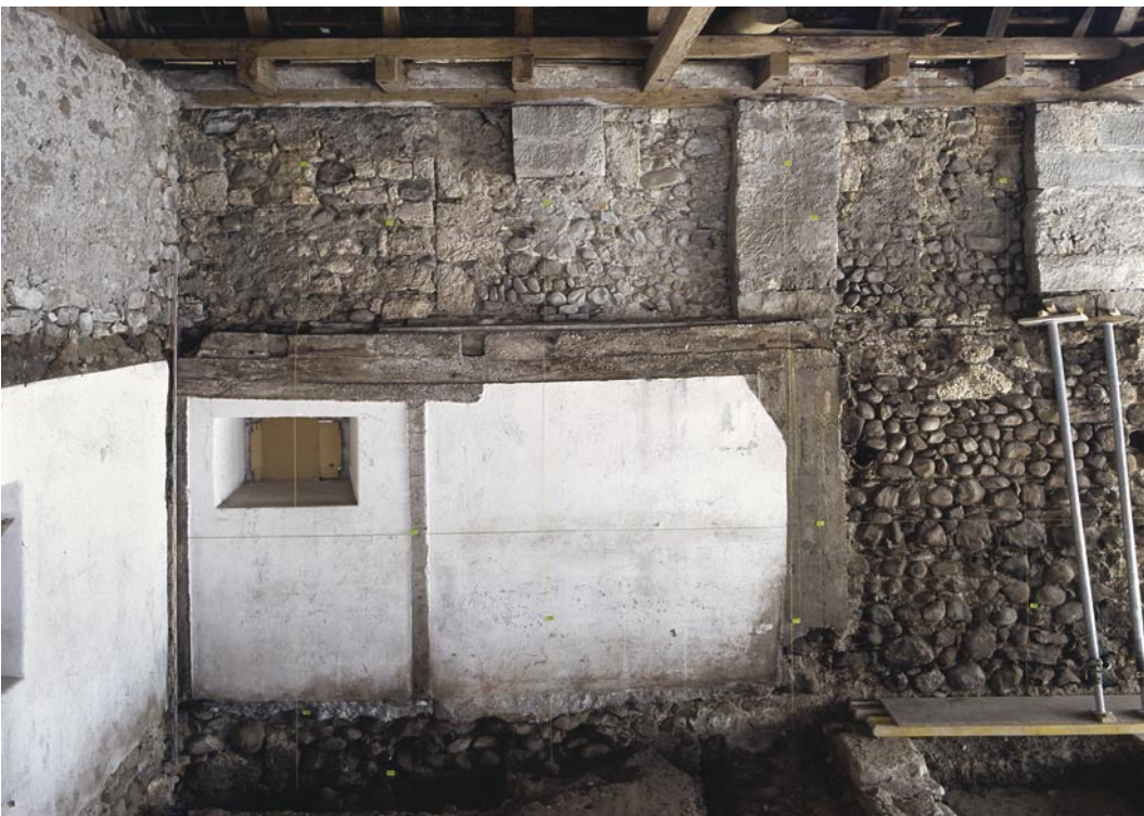
Abb. 6: Köniz, Schloss, Mühlenstrasse 15. Ansicht der Nordmauer. Die Zinnen aus Tuffsteinquadern wurden durch die modernen Sandsteinpfeiler gestört.
