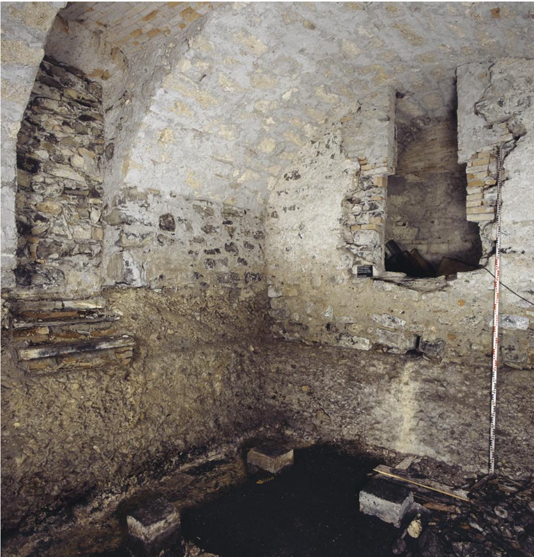
Abb. 4: Hilterfingen, Schloss Hünegg. Das Innere des Gewölbe- / Eiskellers nach Osten. Links der vermauerte originale Zugang in den barocken Gewölbekeller.
