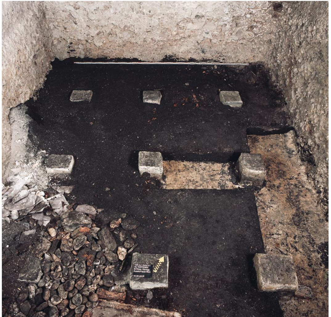
Abb. 5: Hilterfingen, Schloss Hünegg. Am Boden des Eiskellers ist die Schlackenschicht zu sehen, rechts und in der Bildmitte in Streifen freigelegt der Mörtelboden.
