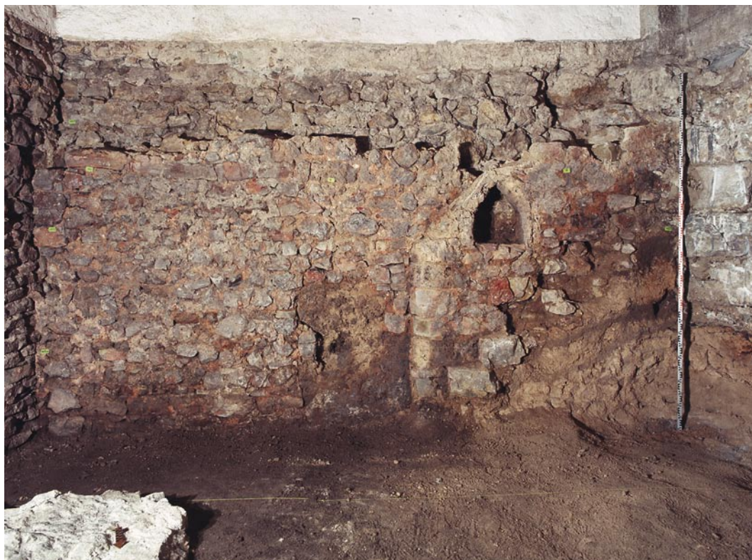
Abb. 4: Biel, Obergasse 4, Kellersüdwand. Ansicht der Mauern (3) / (9) während der Dokumentationsarbeit. Die Mauer (3) wurde der älteren Mauer (9) vorgeblendet. Der Verlauf der abgebrochenen Treppe von der Gasse her ist deutlich erkennbar. Die giebelartige Lichtnische diente zur Aufnahme eines Talglämpchens zur Beleuchtung. Der oberhalb der Treppe parallel verlaufende Vorsprung könnte ein Hinweis auf eine Holzterrasse sein, welche in den Raum über dem Keller führte.
