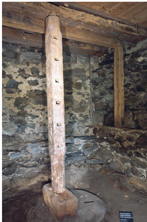
Abb. 3: Innertkirchen, Wylers-Sunnsyten 14. Inneres des Kellers. In der Mitte der drehbare Pfosten.
