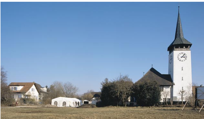
Abb. 1: Hasle bei Burgdorf, Kirchmatte. Übersicht über das Gelände. Rechts die Pfarrkirche, links das Grabungszelt.
