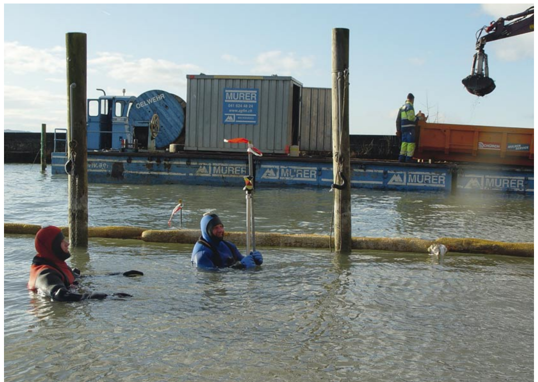
Abb. 1: Biel-Vingelz, Hafen. Arbeitssituation mit Marco Amstutz und Rolf Stettler im Januar 2008 während den Bohrsondierungen.
