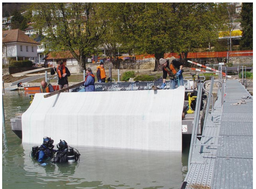
Abb. 6: Biel-Vingelz, Hafen. Schutz der jungsteinzeitlichen Siedlungsschichten im Hafenbereich durch die Verlegung von Geotextil.
