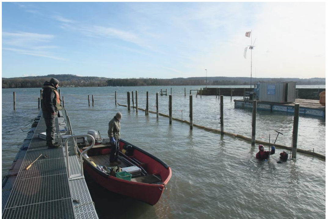
Abb. 4: Biel-Vingelz, Hafen. Bohrsondierung der Tauchequipage des ADB, Januar 2008, im Hafenbecken.
