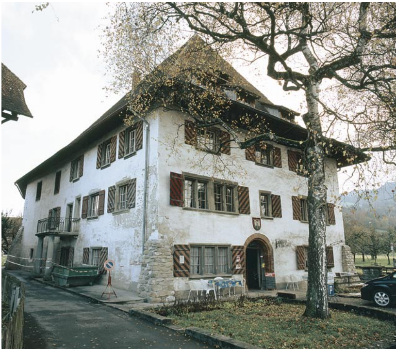
Abb. 1: Steffisburg, Höchhus. Das grosse Höchhus im Zustand kurz vor den Restaurierungsarbeiten.
