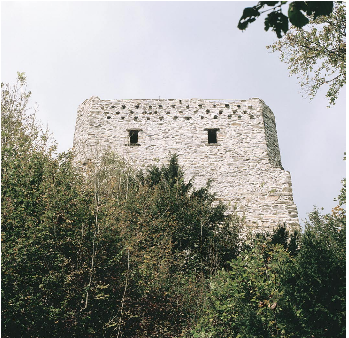
Abb. 5: Ringgenberg, Burg- ruine. Südfassade mit Brut- nischen und Fenstern des Festsaals. Deutlich ist die Abschrägung der Ecken am oberen Turmteil sichtbar.
