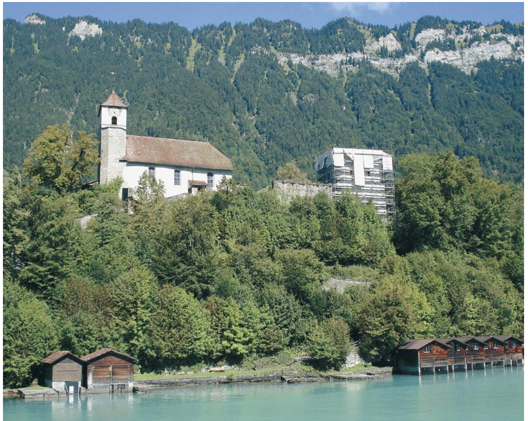
Abb. 1: Ringgenberg, Burgruine. Übersicht vom See während der Turmsanierung.
