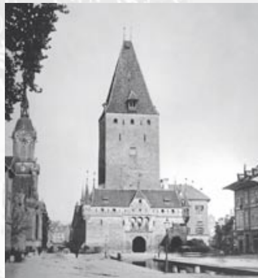
Christoffelturm und Zwingenanlage kurz vor der Zerstörung um 1865.
