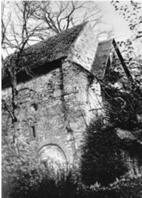
Haberhaus von Südwesten 1880.
