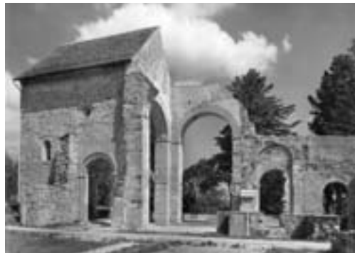
Nordquerhaus nach der Konservierung 1947.
