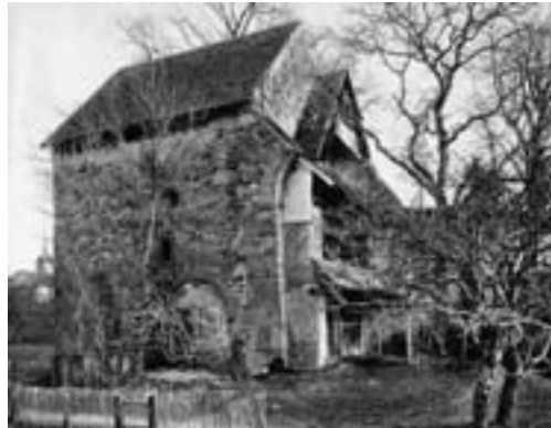
Das sog. Haberhaus von Westen. Zustand vor 1940.
