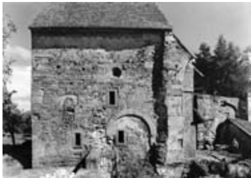
Zustand während der Freilegungen 1940.
